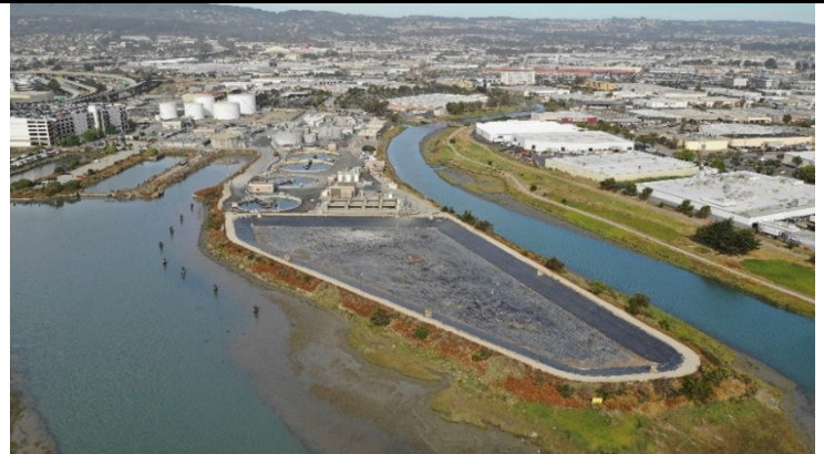
Figure 3. Vista aérea de la planta
